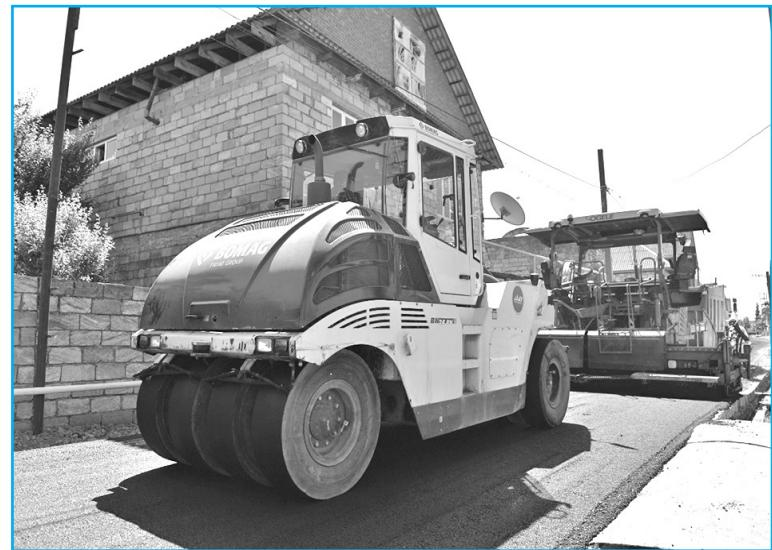
luğu 4,6 kilometr olmaqla 8 küçədə yollara 25000 kvadratmetr asfalt döşənib. Görülən işlər 2020-ci ilin büdcə vasaitləri hesabına hayata keçirilir. Əsaslı şəkildə təmir olunacaq küçələrdə qabaqcadan texnikaların köməyi ilə torpaqlama işləri aparılıb. Yolların yataq hissəsinə çünqil döşənilərək torpaq kipləşdirilib. Yolların təmirini "Lənkərən Yol Tikinti" ASC həyata keçirir.
