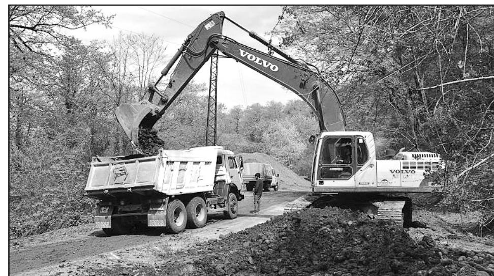
naraq avtoqreyderlərə yayılması və vərdənə ilə kipləşdirilməsi işləri aparılır. Sadalanan işlər yekunlaşandan sonra 80 min kvadrat sahədə yol əsasının 24 sm qalınlıqda qum-çinqıl qarışıqlı ilə alt, 16 sm qalınlıqda isə optimallırmada qarışıqlı ilə üst layının tikintisi işlərinin aparılması nəzərdə tutulub.
